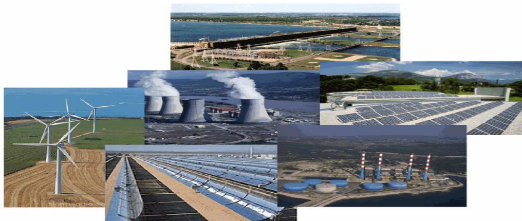
Photo n° 2 : Centrales de grande puissance pour consommations industrielles et urbaines
