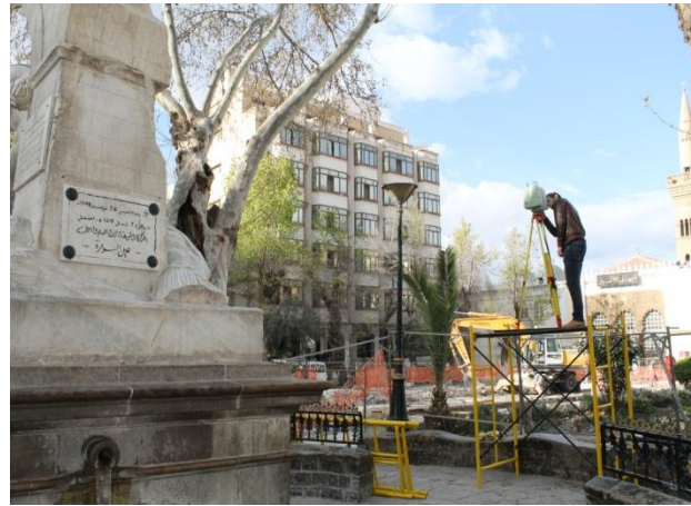
Figure 3 station de relevé laser sur terrain
